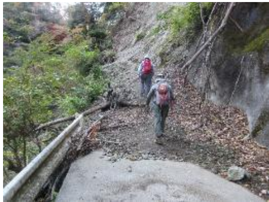
崩落した林道 修復不能？
