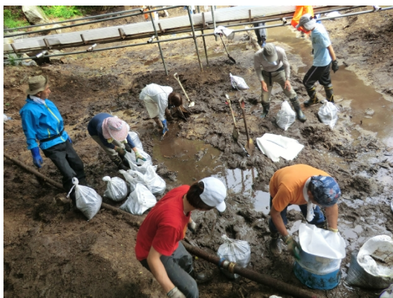
（貯水槽からの土砂の排出）
