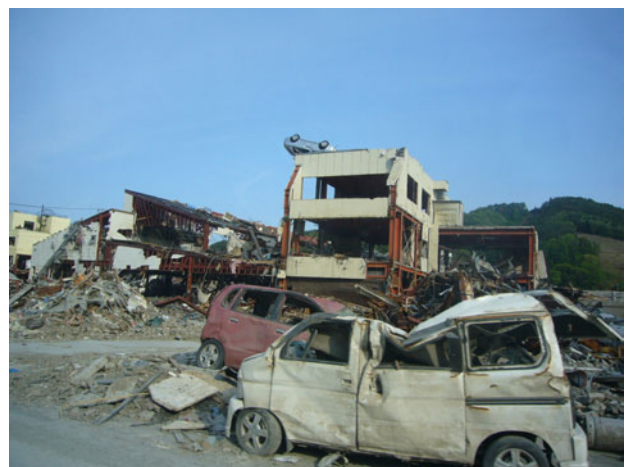
女川町中心部 ビルの上に車が乗っていました。
